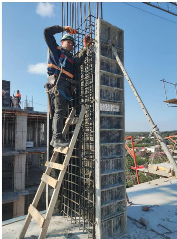
Armado y encofrado de pilares N8-N9
